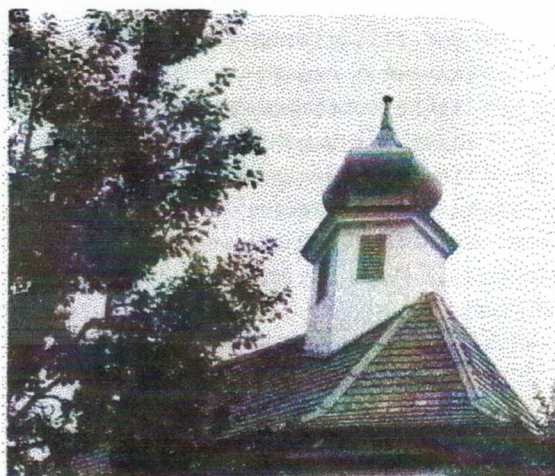
Der sechsseitige Dachreiter wurde 1951 eingeschindelt
